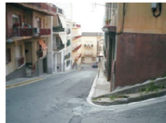
3. Col·locació d'una barana en el tram del carrer Arquitecte Gaudi, des del carrer Pau Costa fins al núm. 13, per facilitar el pas de vianants, ja que la vorera no és plana. 5.500 euros
