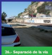
26.- Separació de la via del tren al carrer Fra Pere d'Arenys 8.000 euros
