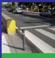
22.- Supressió de barreres arquitectòniques a la part alta i banda de ponent de la Riera 60.000 euros
