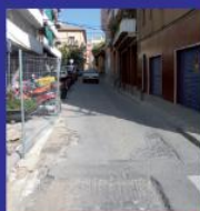
9.- Asfaltat del carrer d'En Riera 17.000 euros
