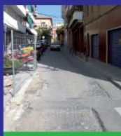
9.- Asfaltat del carrer d'En Riera 17.000 euros
