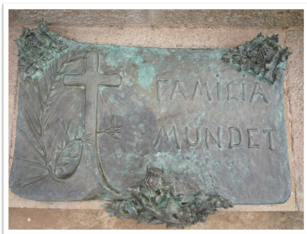
Detall de la placa de bronze una vegada posades les 3 capes finals de protecció
