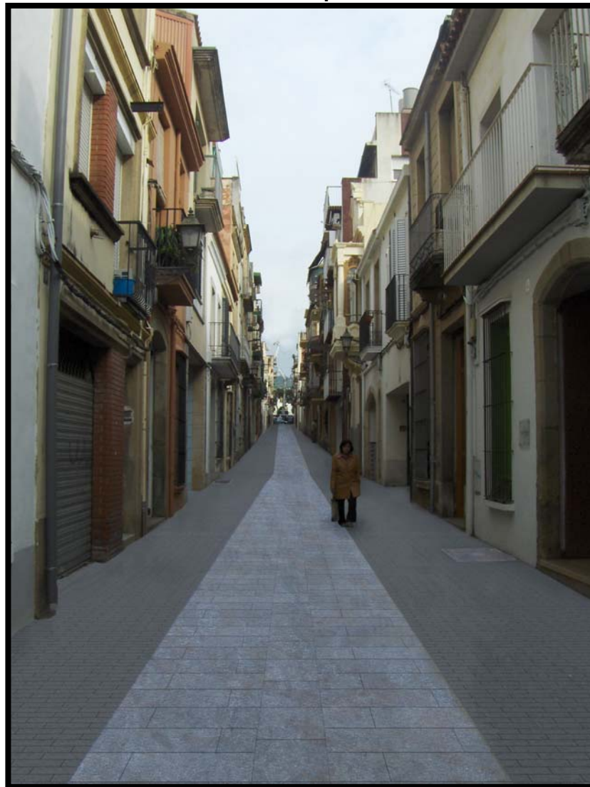
Després de les obres
