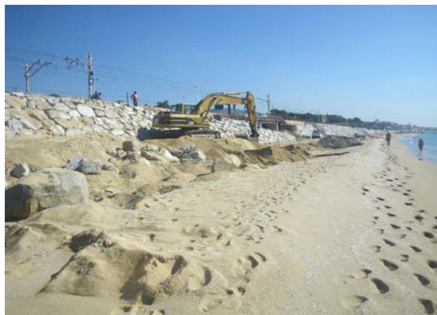
Obres a la platja de Montgat (25-08-2010)
