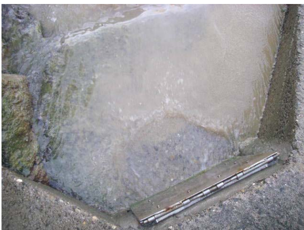
Abocament des del sobreexidor de la platja (01-08-2010)
