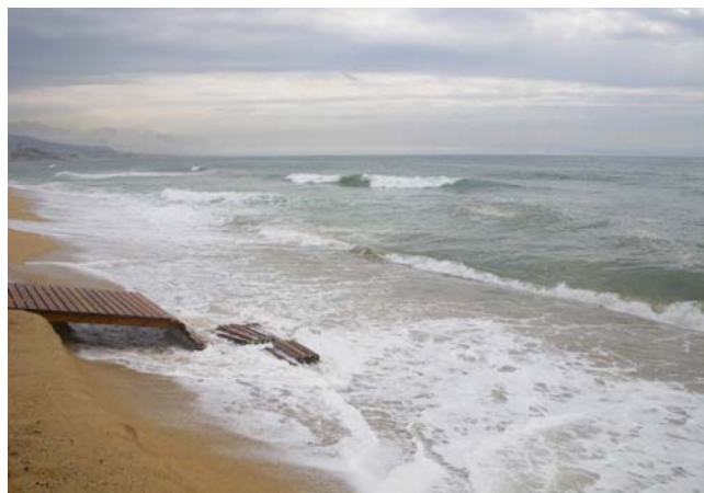
Passarel·la trencada a la platja de Badalona (10-06-2010)
