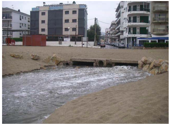
Pluvial de Calafell abocant gran cabal d'aigua a mar (09-06-2010)
