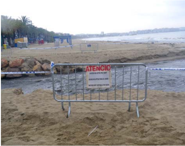
Barranc de Barenys abocant a mar aigües de pluja barrejades amb les residuals (09-06-2010)
