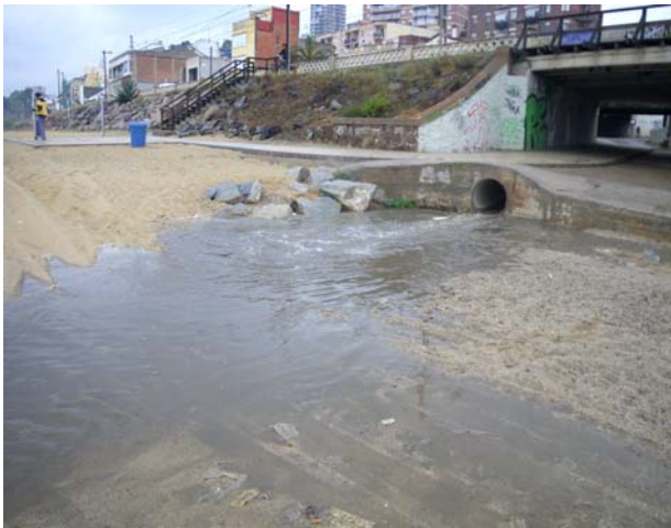
Abocament d'aigües residuals urbanes des d'un sobreexidor a la platja de Montgat (09-06-2010)
