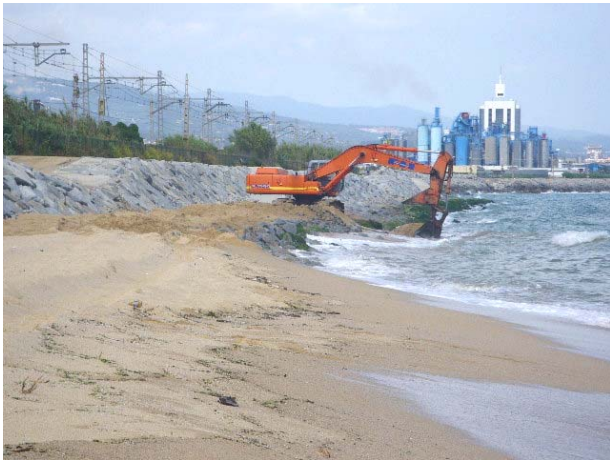
Treballs a la platja de Cabrera de Mar (01-06-2010)
