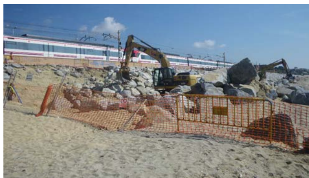
Obres a la platja de Montgat (18-08-2010)
