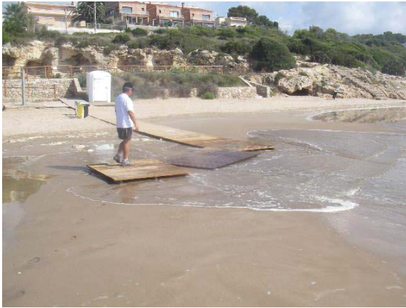
Passarel·la desfalcada per les onades a la platja de Savinosa, a Tarragona (07-09-2010)
