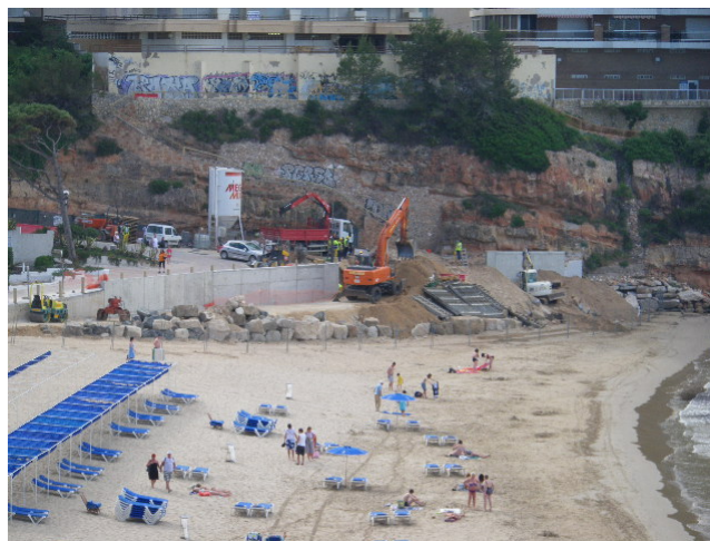
Obres a la Platja de Capellans, a Salou (01-06-2010)
