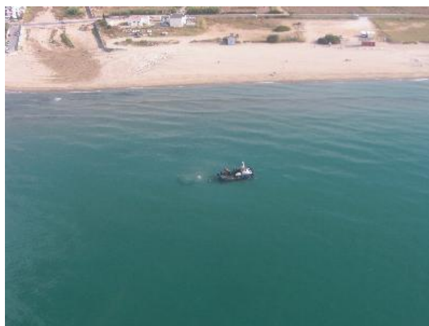
Tasques de reparació de la fuita (20-07-2010)
