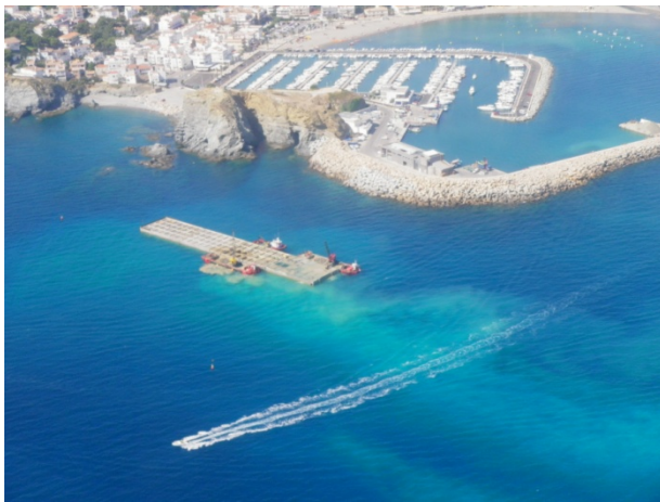
Obres a Llançà (11-07-2011)
