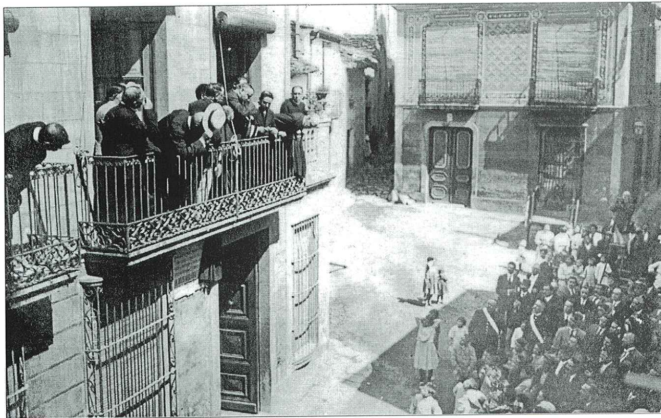
Descobrimet de la làpida en record d'Arnau a la façana de la casa familiar del carrer de la Perera, el 14 de setembre de 1913. (Foto Gaietà Solà, AMFF).
