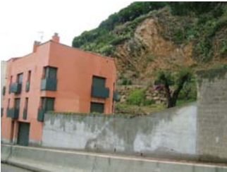
Vista general de l'estat actual de la finca.
