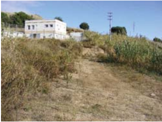
Estat actual de la Depuradora d'Arenys de Mar
