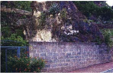
Vista general de la penya un cop realitzada la intervenció.
