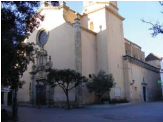
Estat actual de l'església des de la riera.
