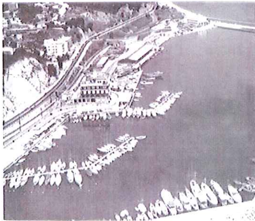
El port abans de la construcció del segon contradic
