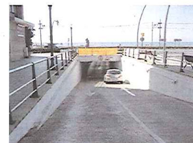
Rampa d'accés al port.
