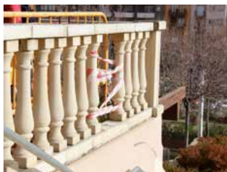
▲ Es repararà la balustrada del Xifré
