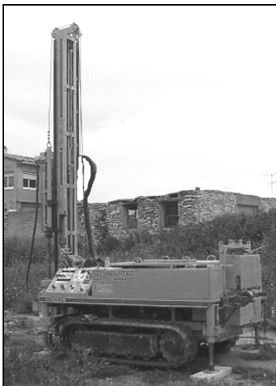
Fotografia 3. Detall de la màquina a rotació ROLATEC, utilitzada.
