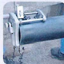
2 Tornear la superficie que estará en contacto con la pieza electrosoldable.
