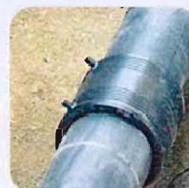
5 Dejar enfriar la unión, como mínimo, el tiempo indicado por la máquina.
