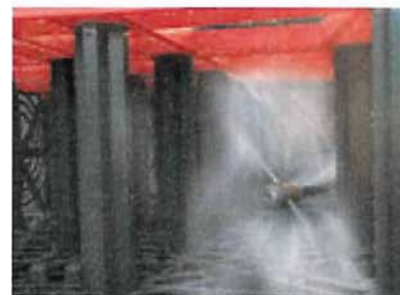
Limpieza con agua a presión
