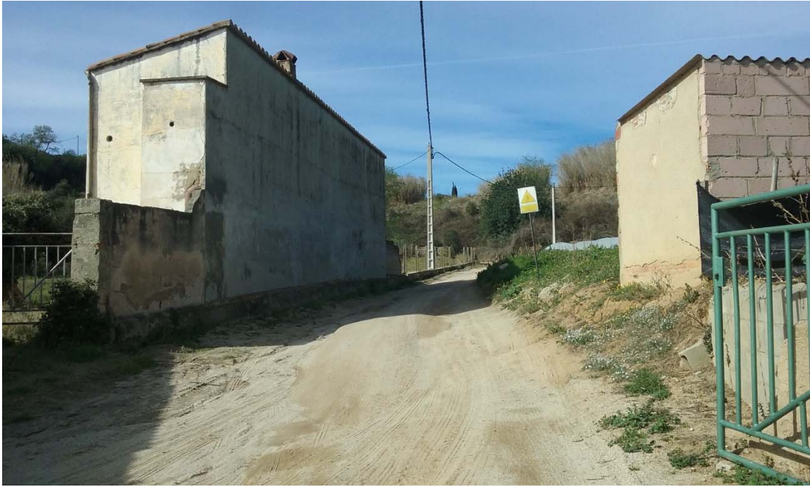
Vista des de l'interior l'àmbit del PPU des del rial Sa Clavella direcció C-32
