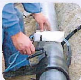
3 Introducir todos los tubos que estarán en contacto con la pieza hasta el tope y en sentido longitudinal.
