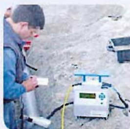
4 Conectar los electrodos a los polos de la pieza e introducir el código de parámetros que viene adjunto a ésta. La máquina comprueba primero la resistencia de la pieza.
