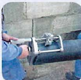
2 Tornear la superficie que estará en contacto con la pieza electrosoldable.
