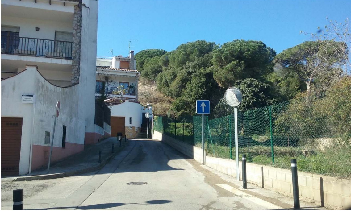
Vista de l'àmbit del PPU des del c/ Barcelona
