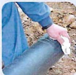
1 Limpiar las superficies de los tubos a soldar.
