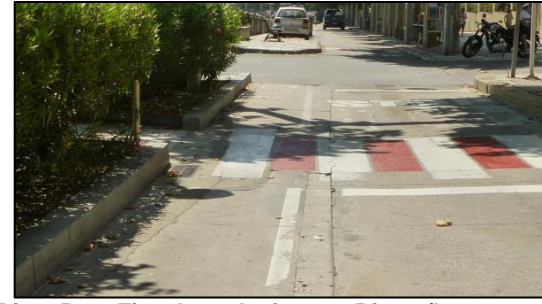
Riera Pare Fita altura Arxipreste Rigau (la tanca vegetal abans del pas dificulta la visibilitat al pas de vianants)
