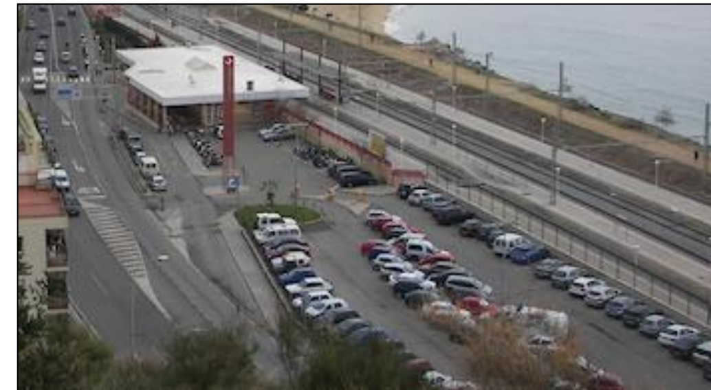
Figura 133 Estat actual aparcament Estació Rodalies (1)
