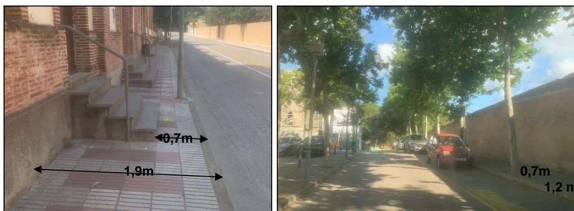
Figura 11. Detall estretament per edificació carrer Santa Clara i per mur carrer d'Auterive
