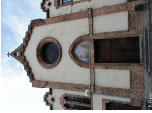
Estat actual de la façana de l'església al carrer de Santa Clara
