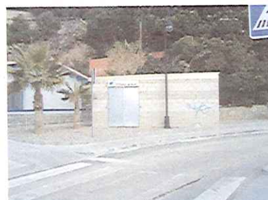
Estació de bombament aigües residuals
