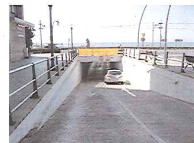
Rampa d'accés al port.
