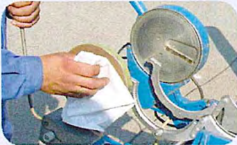
1 Limpiar de residuos y grasa la placa calefactora con papel y alcohol.
