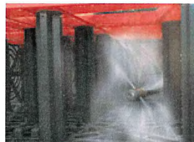
Limpieza con agua a presión
