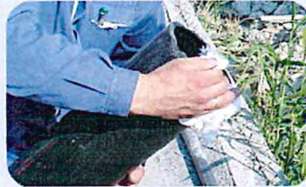
2 Limpiar las superficies a soldar de ambos tubos.
