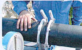
5 Enfrentar los tubos y volver a comprobar que están alineados.
