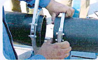
3 Colocar los tubos alineados y sujetarlos mediante las mordazas de la máquina, dejando espacio entre ellos para que pueda actuar la biseladora.
