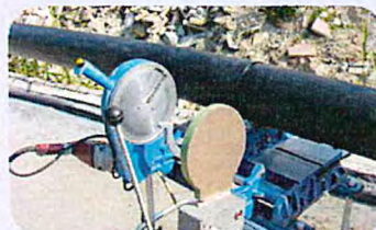
9 Dejar enfriar la soldadura, teniendo en cuenta que se enfría más rápido por el exterior.
