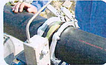
6 Colocar la placa calefactora entre ambos tubos y aproximarlos a ella, comprobando que hagan buen contacto a lo largo de todo su perímetro.
