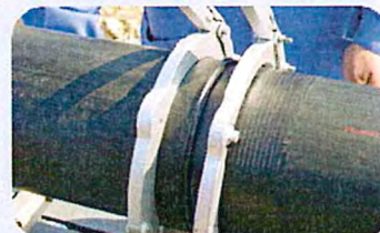
7 Calentar ambas superficies manteniendo la presión hasta que toda ella haga buen contacto. A partir de ahí, mantener la plancha sin presión hasta conseguir la altura de bordón necesaria.
