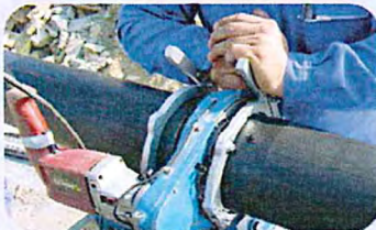
4 Biselar ambos tubos a la vez y eliminar las virutas generadas.
