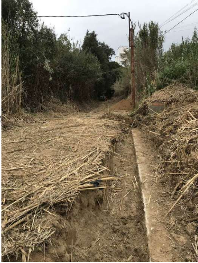
Zona intermèdia del Rial, on ha aflorat l'antic mur de separació entre domini públic i propietat privada, i que estava tapat degut a la sedimentació i manca de neteja del Rial. Abans del pal de fusta, el mur s'acaba. Font: pròpia.
