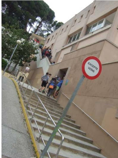
Accés actual a l'escola a través de les escales laterals des del carrer Passatge Vallgorguina
