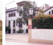
14. Arranjament integral de la façana del C.C. Calsay. 20.000 euros
