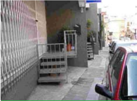
10- Arranjament de la vorera del carrer Anselm Clavé 62-64-66
