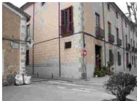
17- Senyalització del pas de vianants i supressió de barreres arquitectòniques del carrer d'Avall amb la Riera
