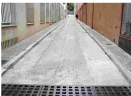
7- Pavimentació del carrer Sant Roc 20.000 euros
