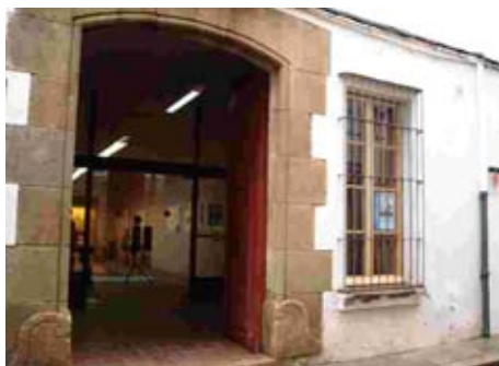
5- Rehabilitació de les façanes dels museus de Mineralogia i de les Puntes 30.000 euros
