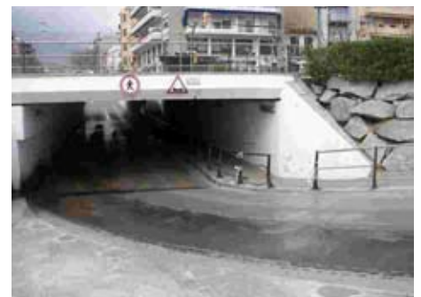
18- Renovació de les baranes del túnel per anar a la platja i de l'ascensor
