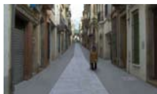
A dalt, vista del carrer Vilà Mateu després de les obres.
